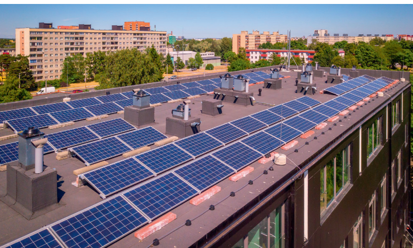
Korterelamu Ehitajate teel. Sharp NDRB275 polükristallpaneelid.
