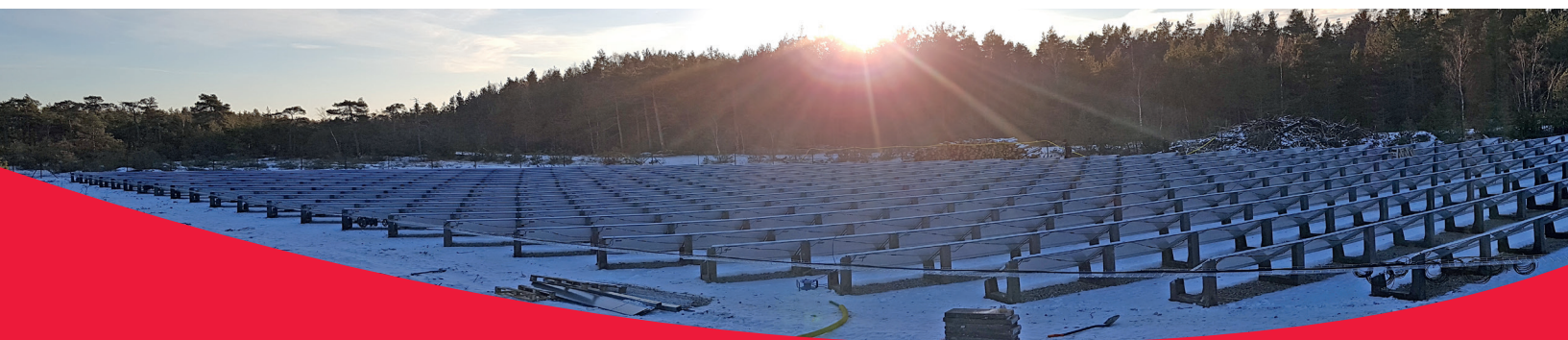
Tallinna Elektriijaam, koguvõimsus 1,2 MW, umbes 4300 Sharpi paneeli.
