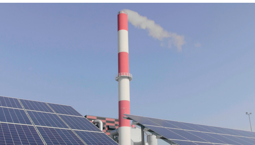
Tallinna Elektriijaam, koguvõimsus 1,2 MW, umbes 4300 Sharpi paneeli.
